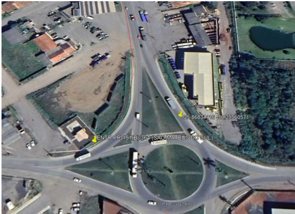
Figura 2 – Ponto inicial dos levantamentos km 277,9 – BR-476/PR Lote 01
