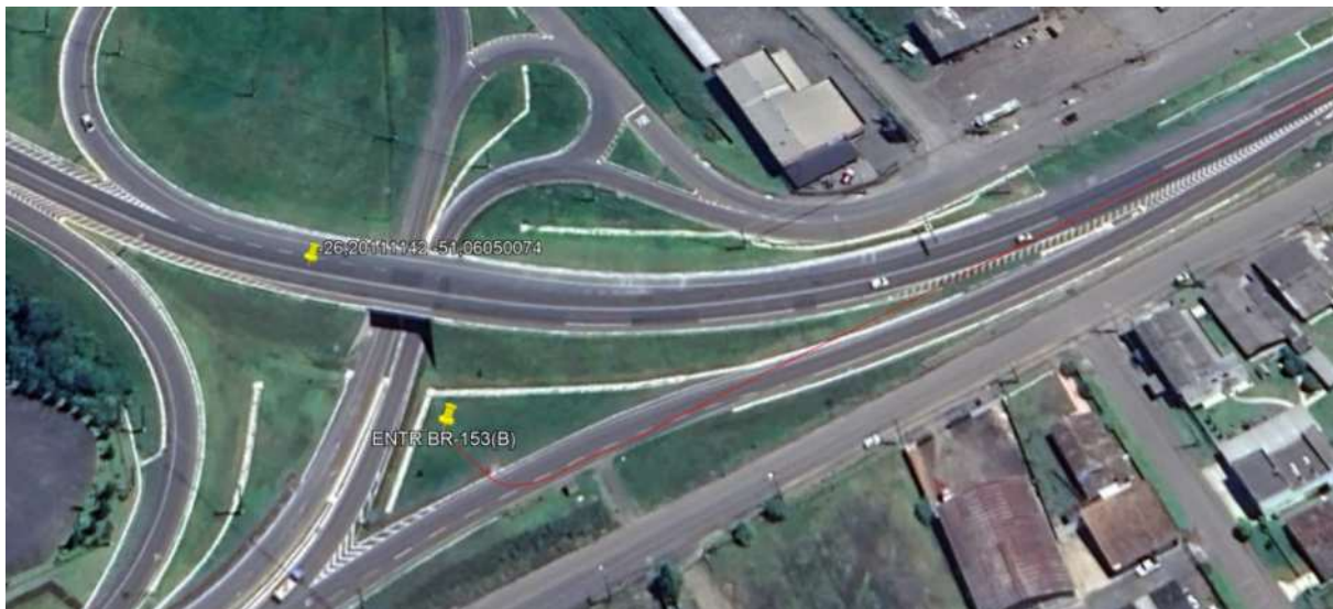
Figura 3 – Ponto final dos levantamentos km 358,6 – BR-476/PR Lote 01
